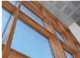
Dettaglio legno interno Internal wood, detail Detalle de madera
