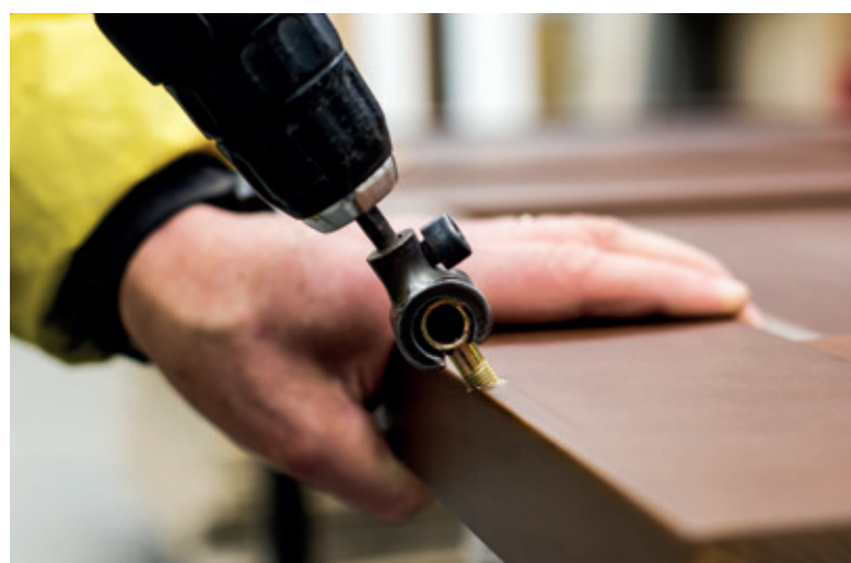
Installazione cerniere Anuba su porta Anuba hinge installation on door Установка ввертных петель
